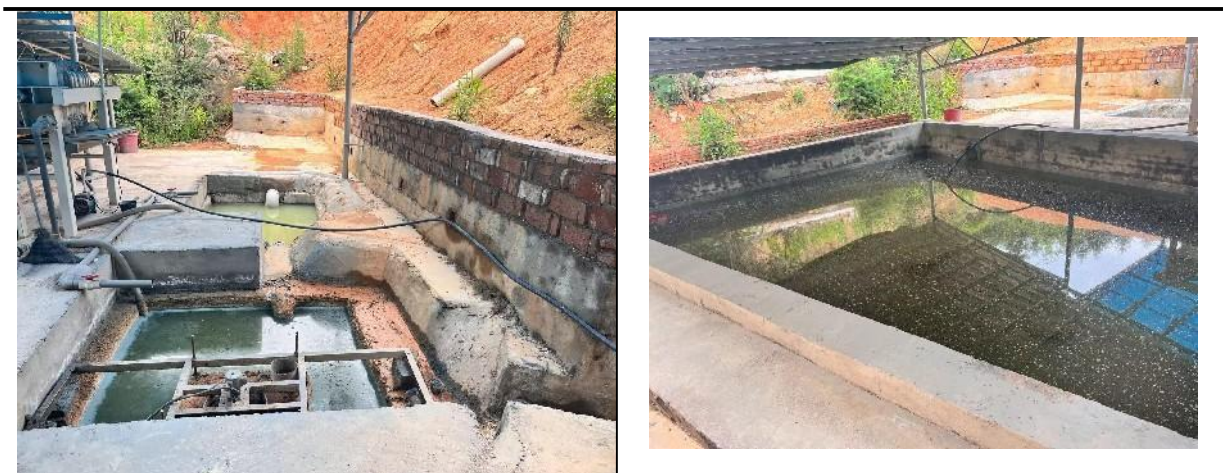
斋江厂区沉淀池
