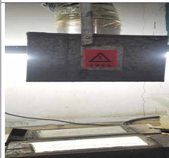
浸锡废气集气罩
