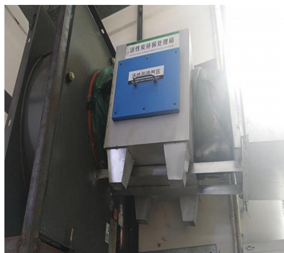
浸锡废气处理装置
