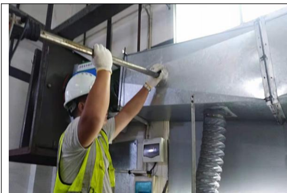
浸锡废气进口采样照片
