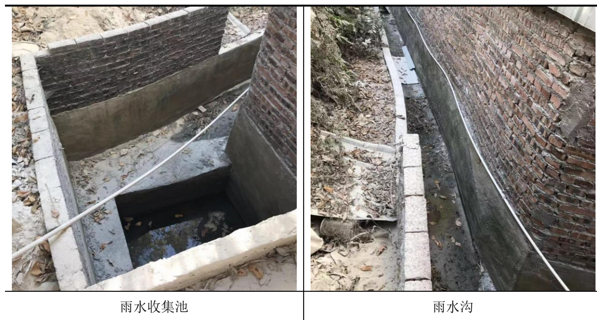
图 4-1 废水处理设施照片
