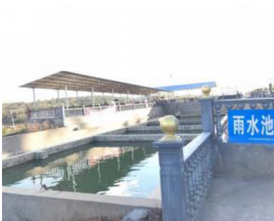
初期雨水沉淀池
