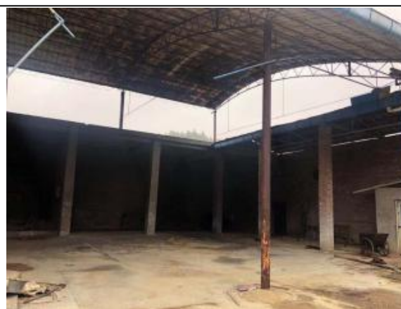
设备拆除照片
