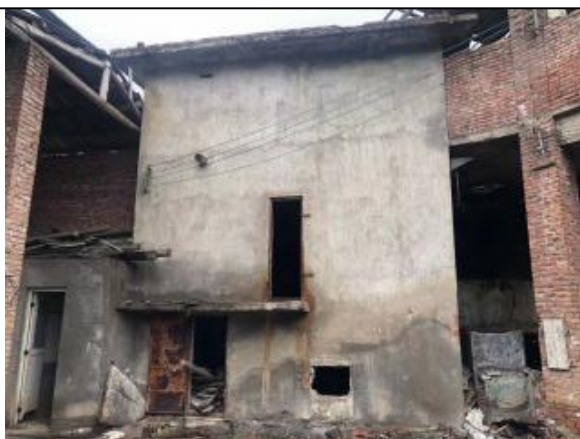
设备拆除照片
