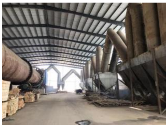
回转窑废气处理设施
