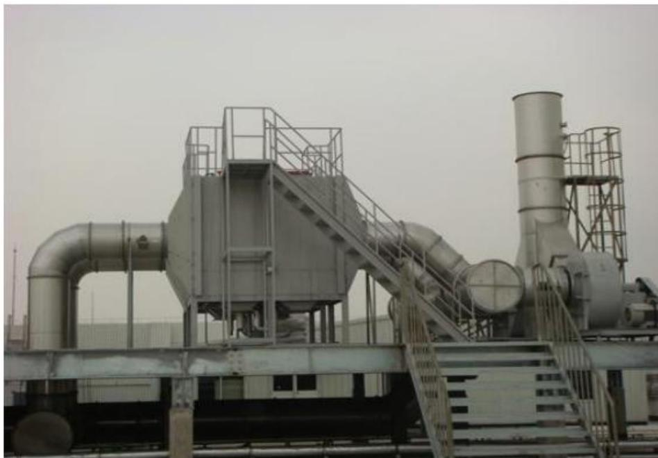
设备处理工艺：废气及大型灰尘集中收集——经过第一道活性炭颗粒吸附，吸附处理 90%以上的废气，更换方式打开料门自动出料更换周期(三个月到半年左右)——最后经过抽风机和管道排放于房顶(备注：第一次的和活性炭我司提供，设备安装完后，主电接通可以直接交给贵司使用)
