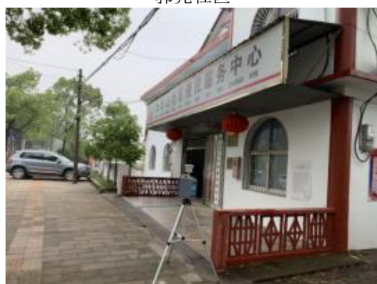
九华山社区居民楼
