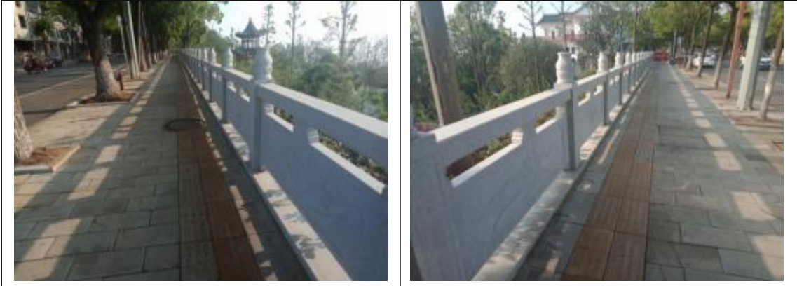
临水域路段防护栏
