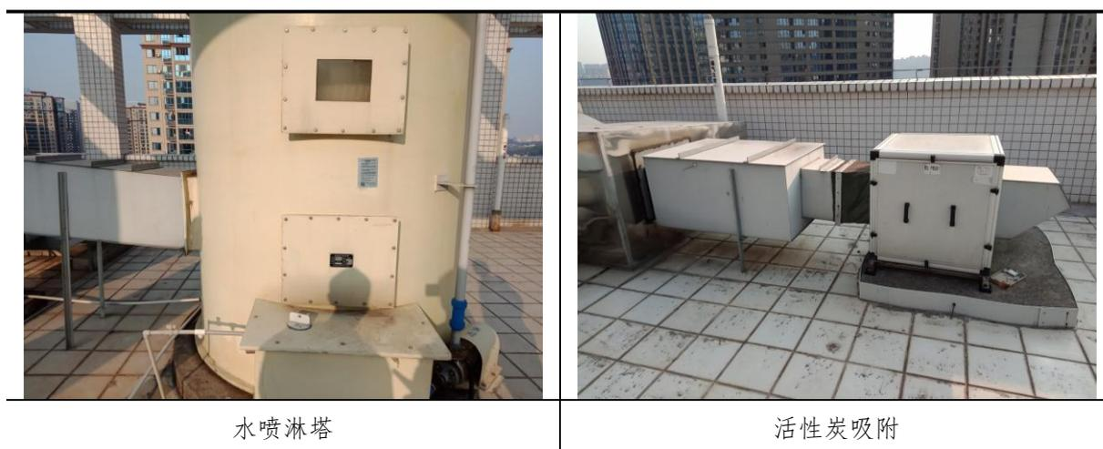
图 4-2 废气处理设施照片
