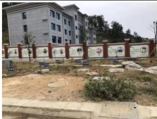
污水处理设施
