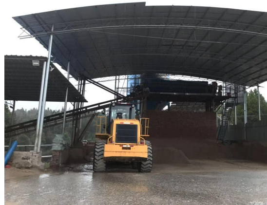
成品堆场设置顶棚+围挡
