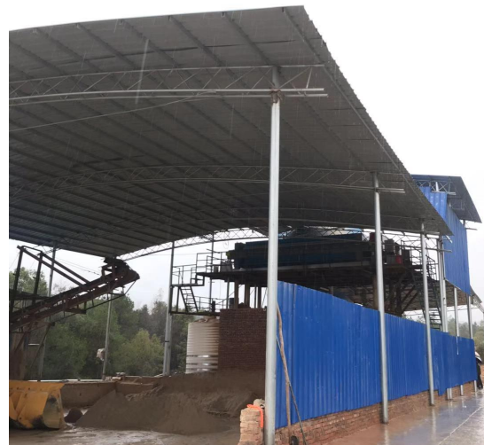
原料堆场设置顶棚+围挡
