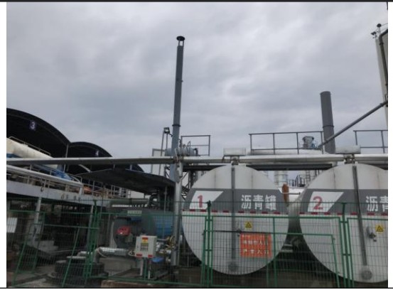
导热炉 8 米高排气筒
